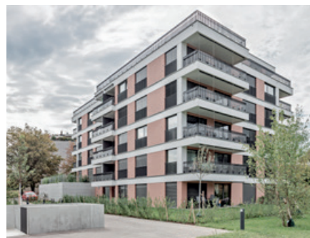
Bad Zurzach Weissensteinweg 1
