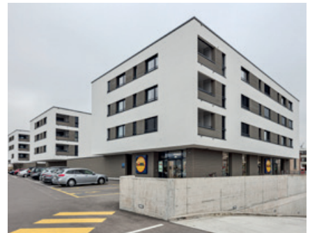
Münchwilen Frauenfelderstrasse 20, 20a, 20b, 20c
