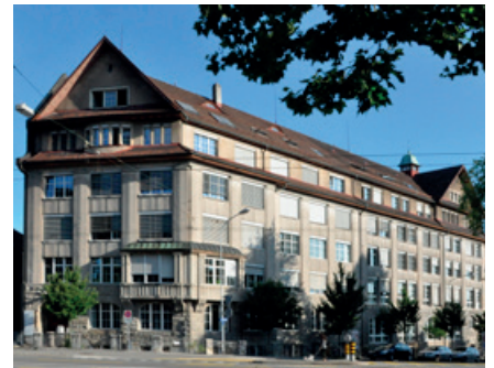
St. Gallen Rorschacherstr. 139, Helvetiastrasse 27
