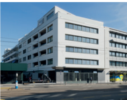
Zürich Badenerstr. 696, J. Fügli-Strasse 16, 18, Bachmattstrasse 53
