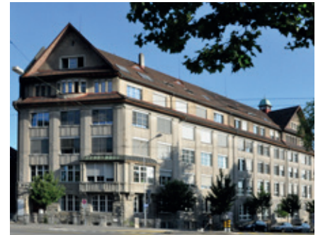
St. Gallen Rorschacherstr. 139, Helvetiastrasse 27
