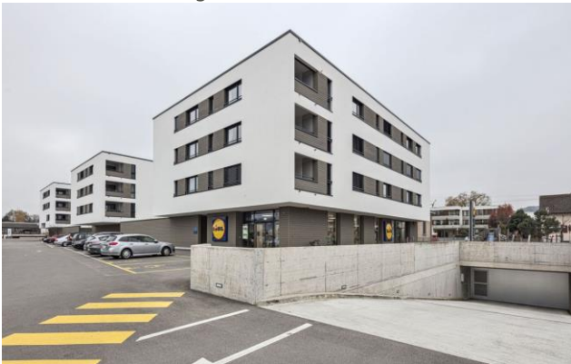
Münchwilen, Frauenfelderstrasse 20, 20a, 20b, 20c
