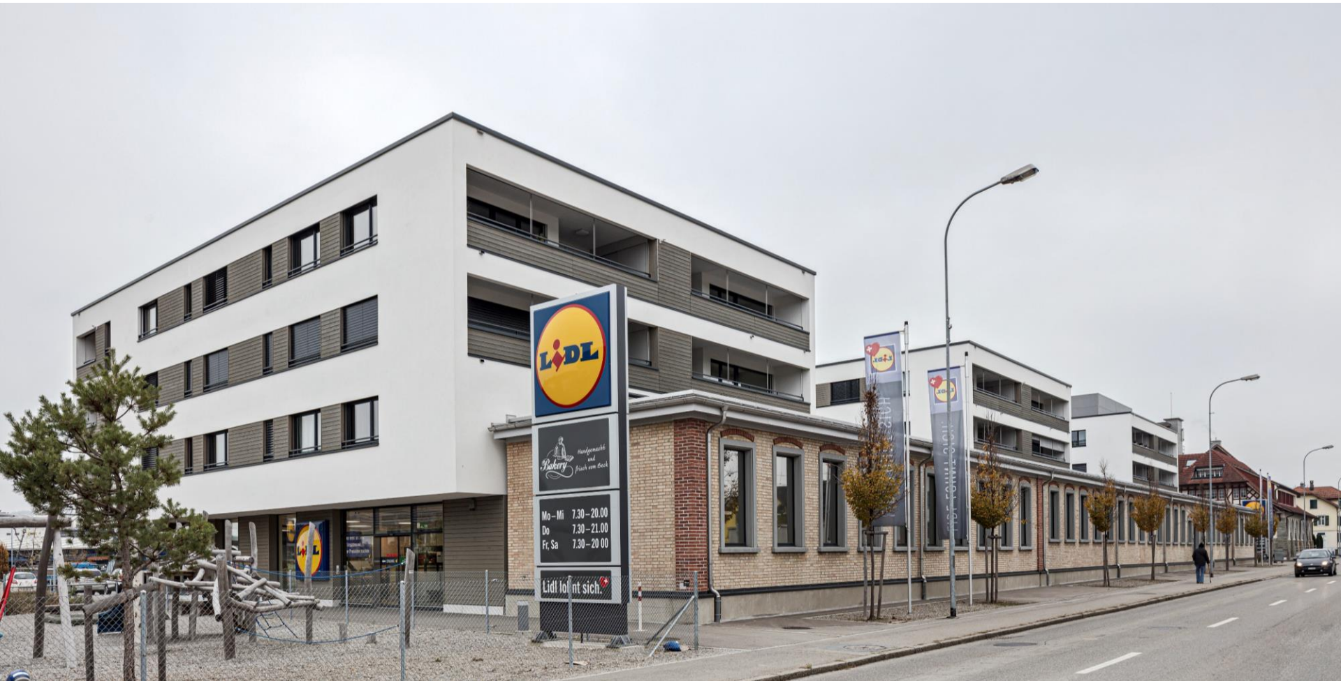
Bild: Münchwilen TG, Frauenfelderstrasse 20, 20a, 20b, 20c
