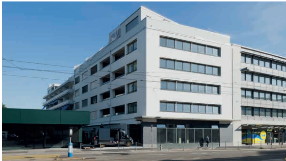
Zürich, Badenerstrasse 696, J. Fügli-Strasse 16, 18, Bachmattstrasse 53
