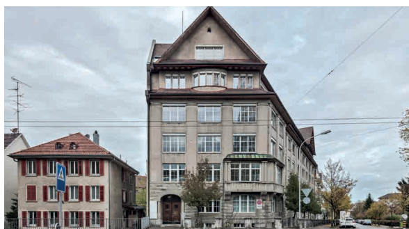
St. Gallen, Rorschacherstrasse 139, Helvetiastrasse 27
