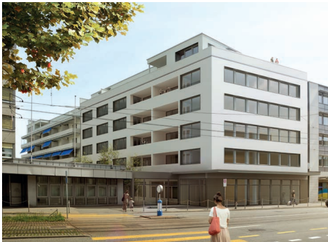
ZÜRICH Badenerstr. 696 / J. Fügli-Str. 16, 18 / Bachmattstr. 53
