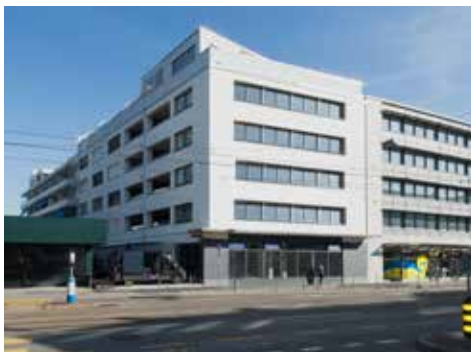
ZÜRICH Badenerstr. 696 / J. Fügli-Str. 16, 18 / Bachmattstr. 53
