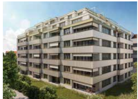
ZÜRICH – UMNUTZUNGSPROJEKT Badenerstrasse 701
