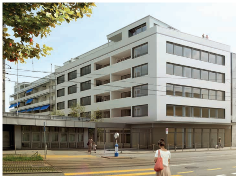
ZÜRICH Badenerstr. 696 / J. Fügli-Str. 16, 18 / Bachmattstr. 53
