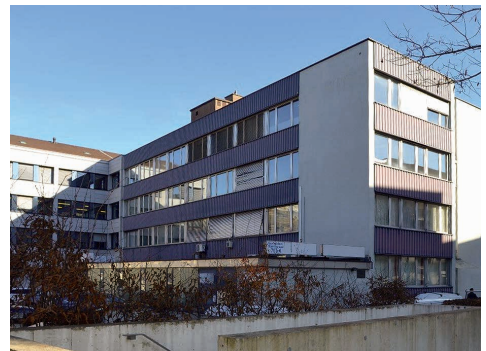
ZÜRICH – UMNUTZUNGSPROJEKT Badenerstrasse 701
